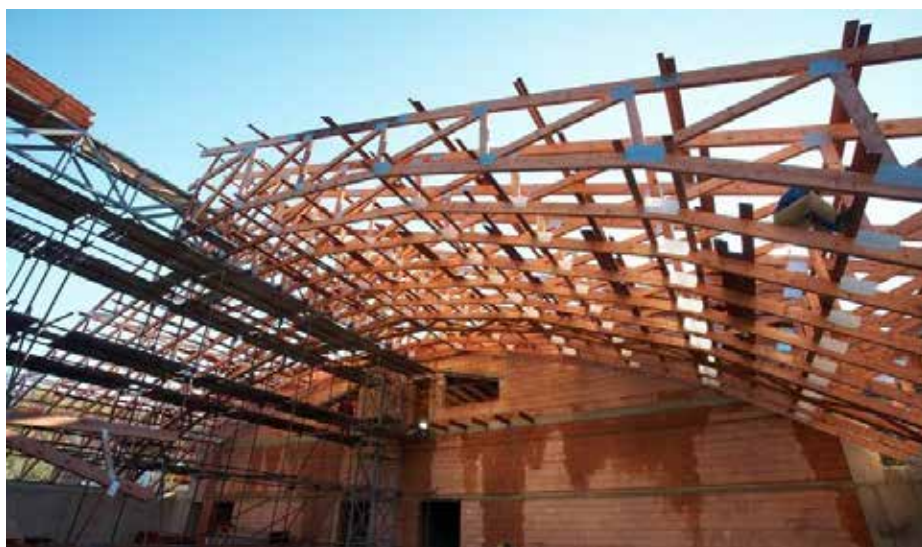
Tenisové hala - technologie dřevěných příhradových vazníků se stýčnickovou deskou Hala tenisowa - technologia konstrukcji kratowych łączonych płytkami z blachy
