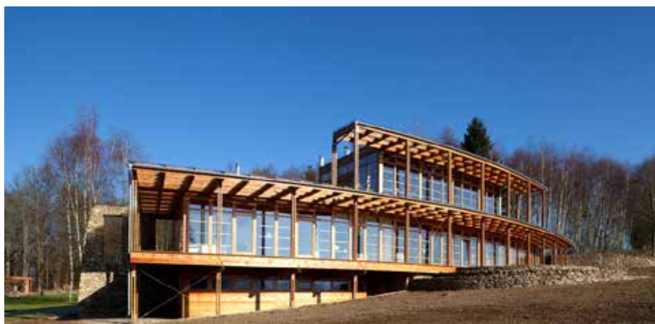
Dům v oboře - dřevěný skelet z masivního dřeva (modřín) opracowanego na CNC obráběcím stroji Hundegger Drewniana konstrukcja wykonana z litego drewna (modrzew) obrobionego na maszynie CNC firmy Hundegger
