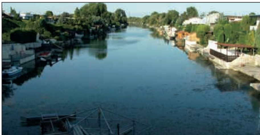
Kanał Odra – Dunaj niedaleko Wiednia wybudowany w latach 1939-1943 / Kanál Odra – Dunaj postavený nedaleko Vídně v letech 1939-1943
